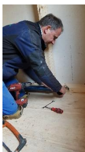
Bild 3 – 4: Thomas Bochtler und Tagespraktikantin Silke Ulrich installieren das Verteilersystem einer Fußbodenheizung.
